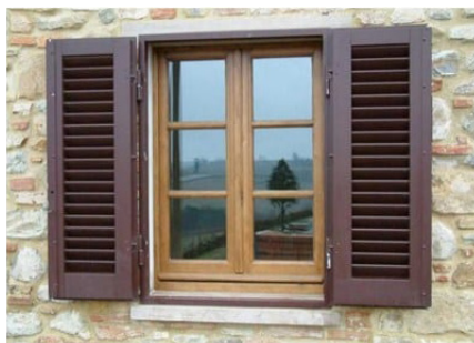
Gambar 12. Pemasangan kaca pada kusen kayu Sumber: Tina Kliment/ https://www.pinterest.com/pin/288652657348333467/
